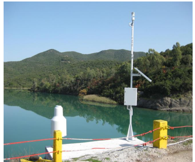
Σταθμός λίμνης Καστρακίου
